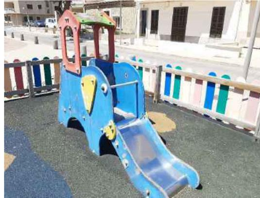
Maderas muy desgastadas, astillamiento en sección de deslizamiento.
