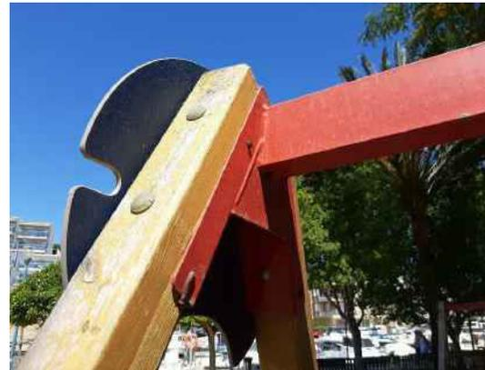
Columpio mal instalado. Pintas retorcidas en vez de tornillería
